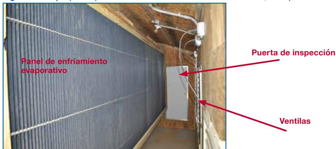
Para que el sistema de ventilación de túnel funcione eficientemente, es importante que el área de paneles de enfriamiento se calcule de manera apropiada según la capacidad total de operación de los ventiladores.
