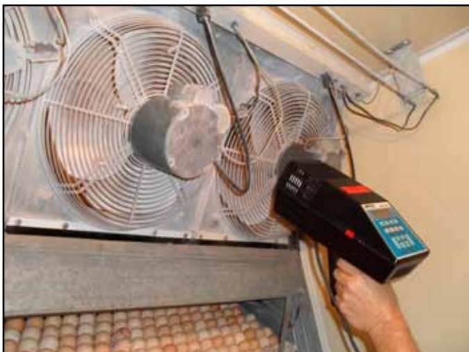
Фигура 6: Използване на стробоскопична светлина за проверка скоростта на вентилаторите.
