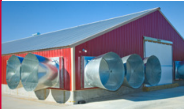
Σχήμα 107 Παράδειγμα τυπικού κτιρίου με αερισμό τούνελ.
