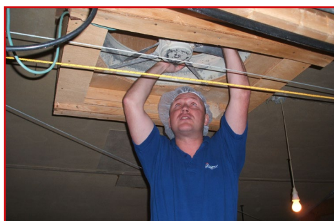
Csapágy és motor ellenőrzése
