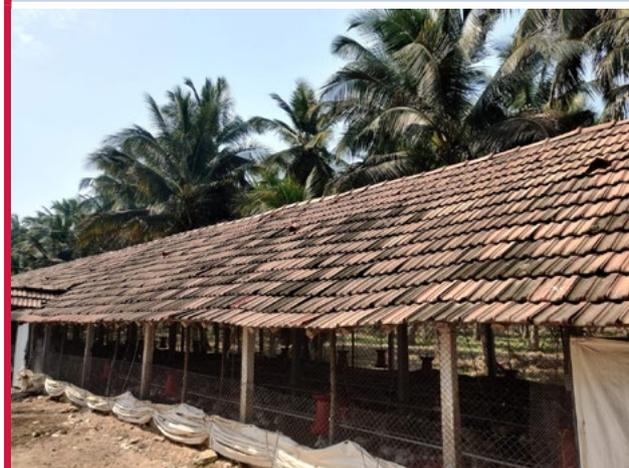
O fluxo de ar em galpões abertos é controlado variando a abertura das cortinas. As cortinas devem ser fixadas na parte inferior da parede lateral e ser abertas de cima para baixo para reduzir o vento ou as correntes de ar que sopram diretamente sobre as aves.
