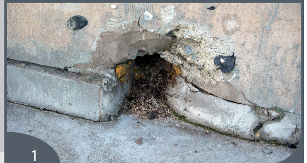
Excavaciones en las fundaciones de la edificación.
