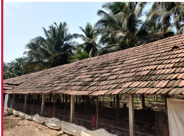
El flujo de aire en los galpones abiertos está controlado por la variación en la abertura de las cortinas. Las cortinas deben fijarse en la parte inferior de pared lateral y deben abrirse de arriba hacia abajo para minimizar que el viento o las corrientes de aire pasen directamente por las aves.
