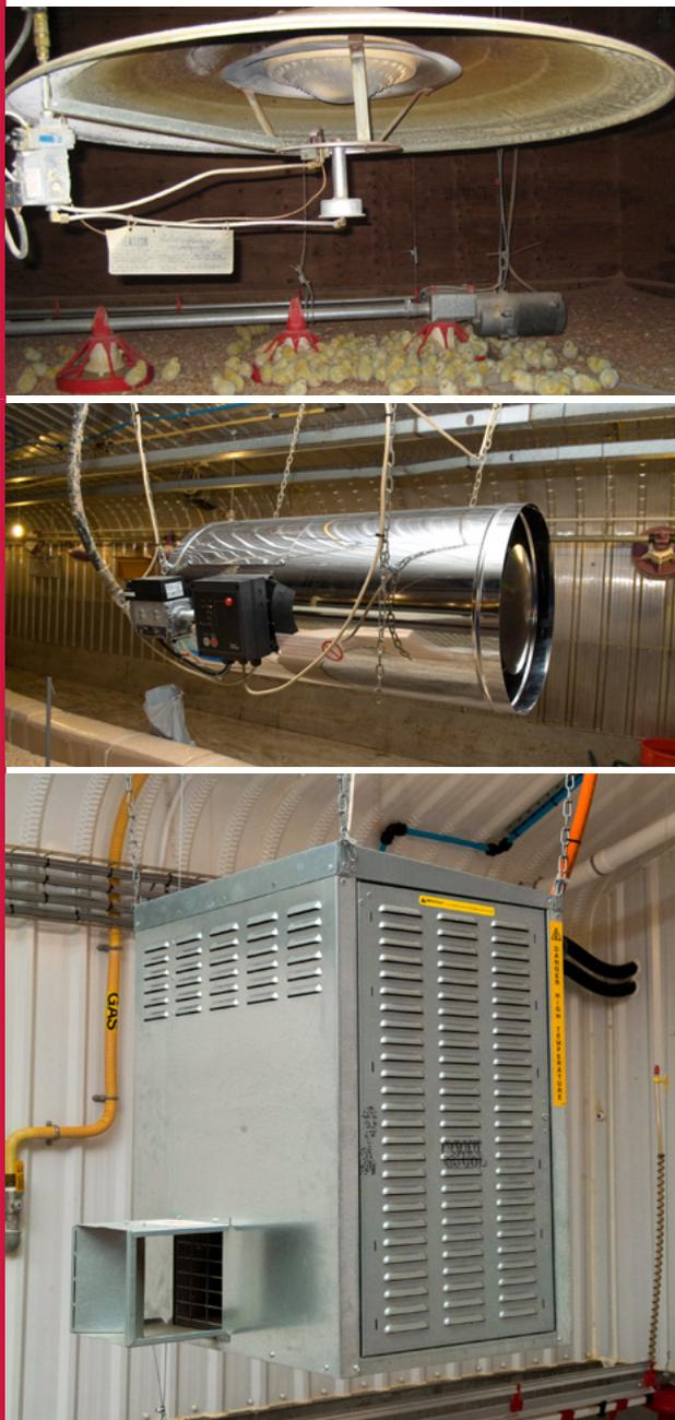
El sistema de calefacción debe proporcionar una capacidad suficiente para mantener la temperatura deseada del galpón en los períodos de más frío y a la vez permitir que se cumplan los requisitos mínimos de ventilación. El calor debe distribuirse uniformemente en todo el galpón y debe funcionar en combinación con el sistema de control de ventilación principal.
