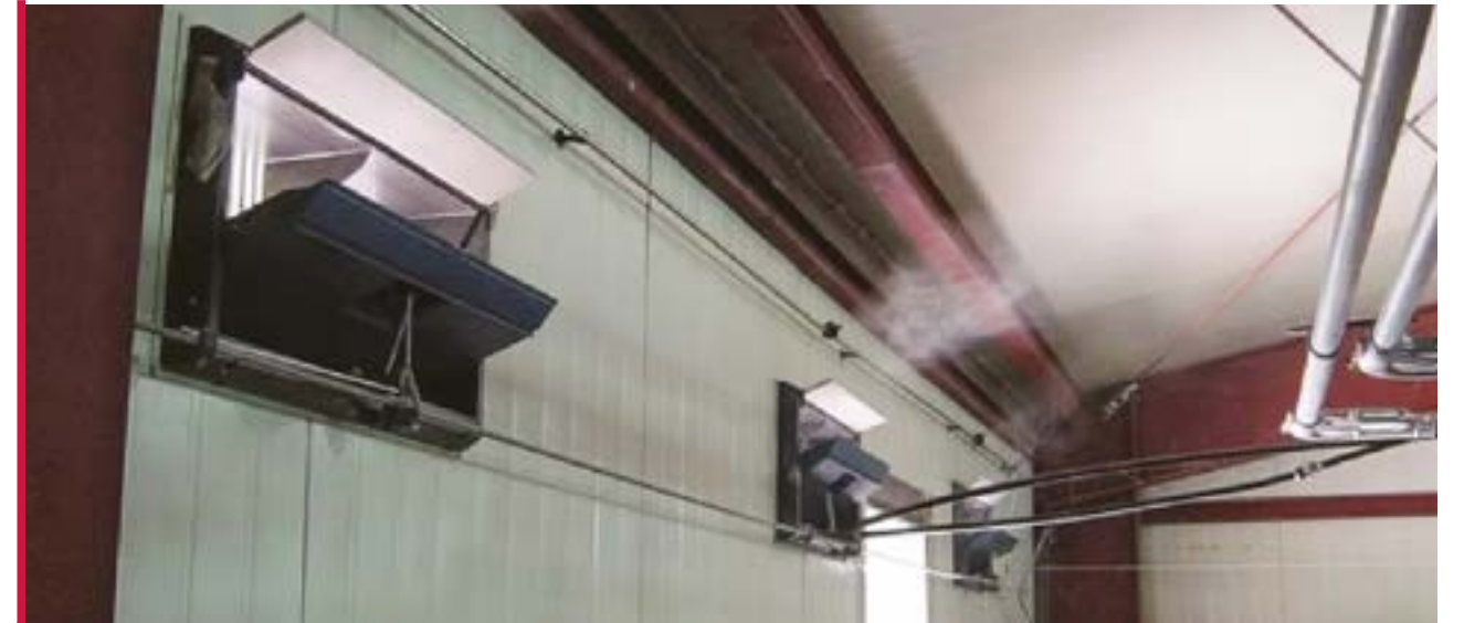
Şekil 6.25 Çapraz havalandırmada bir kümeste sisleme sistemi örneği.
